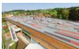
Centre of generations Spitzer GmbH Dachdeckerei- Spenglerei Austria
